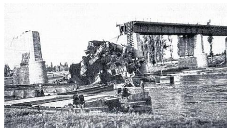
📷 Der Anfang vom Ende: Wehrmachtssoldaten sprengten am 4. April 1945 die Eisenbahnbrücke über den Main in Kitzingen. Die Brücke wurde nie mehr aufgebaut, so dass die Nebenbahn Schweinfurt-Kitzingen seit Kriegsende keine direkte Verbindung mehr zur Hauptstrecke Nürnberg-Würzburg hatte. Foto:
