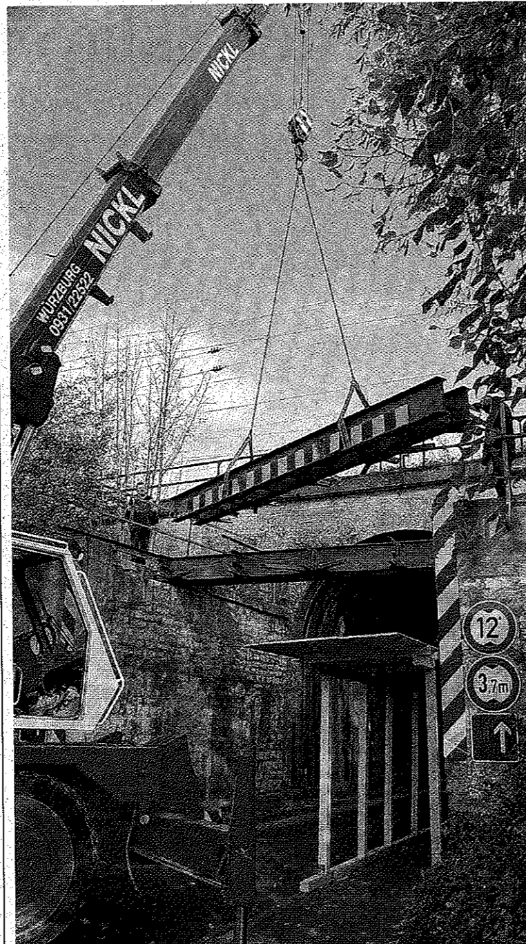
Wenig Mühe hatte am Montag dieser 20-Tonnen Kran, der in kürzester Zeit die vier Doppel-T-Träger der ehemaligen Eisenbahnbrücke an der Inneren Sulzfelder Straße aus ihren Verankerungen hob und auf einen Lkw verfrachtete. FOTO RALF WEISKOPF
