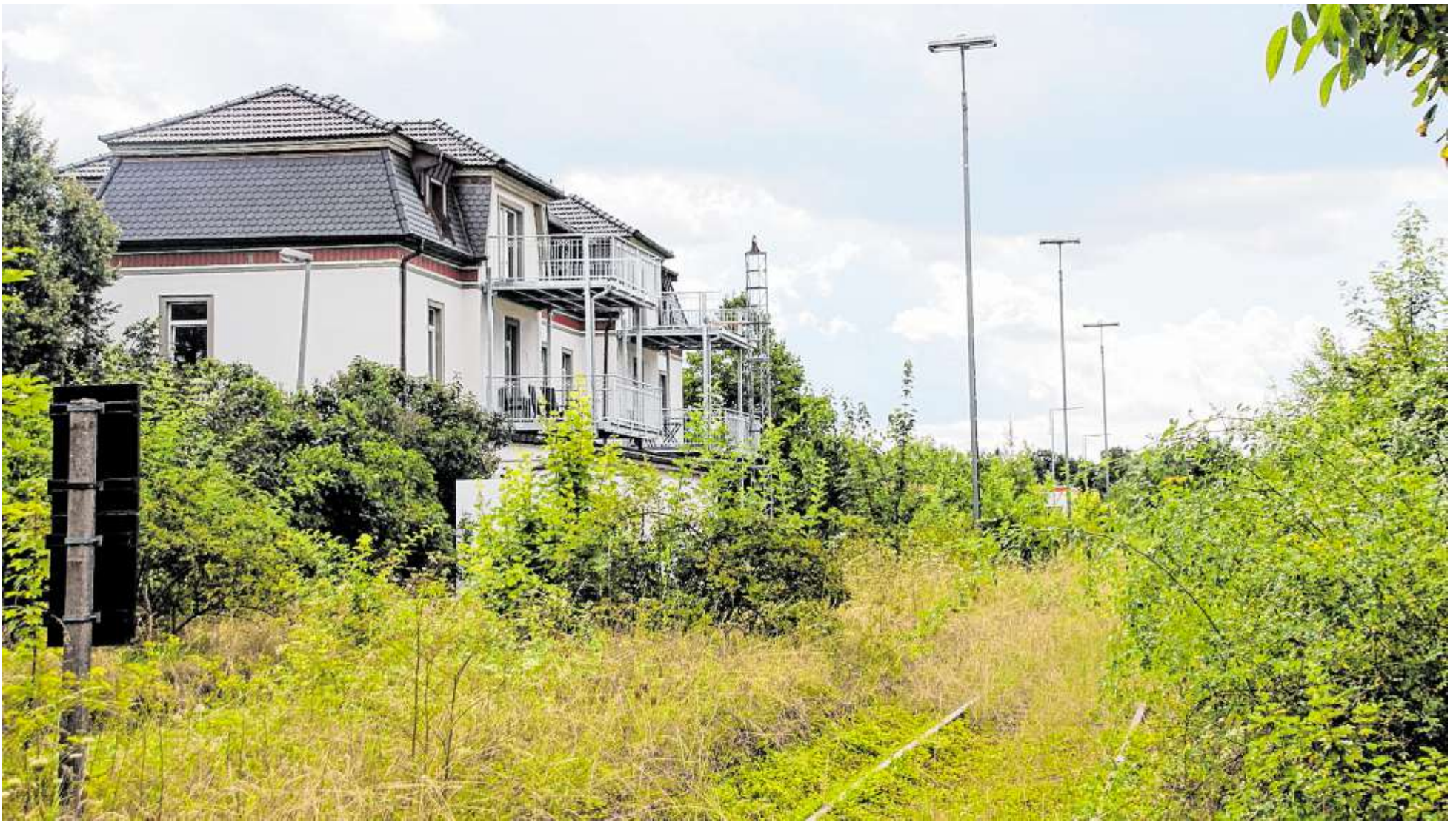
Nachdem mit der Stilllegung der Bahnlinie Kitzingen/Etawahausen – Gochsheim niemand mehr für die Strecke zuständig ist, geht der Wildwuchs in noch stärkerem Ausmaß weiter. Das Bild entstand am Gerolzhöfer Bahnhof. FOTO: NORBERT FINSTER
