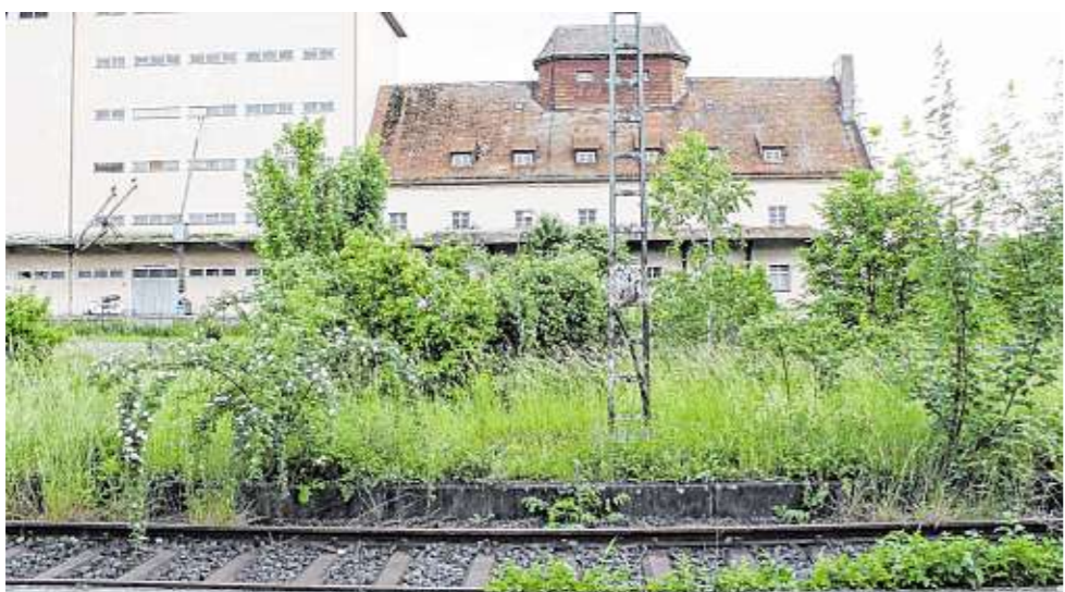
Während bei „Gleis 1“ (im Vordergrund) offenbar noch die alten Pflanzenschutzmittel der Bahn wirken, ist das „Gleis 2“ schon komplett zugewuchert. Und die mächtigen Gebäude der BayWa im Hintergrund warten auf die Spitzhacke. FOTO: KLAUS VOGT
